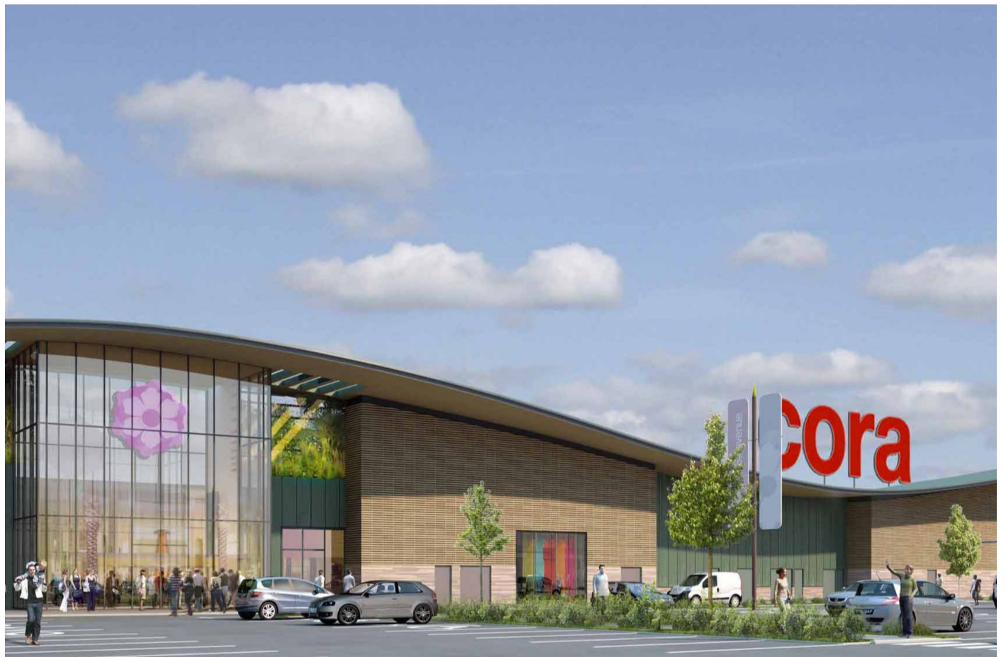
Allure vallonnée pour la façade revue de Cora. (Document du cabinet Outsign Architecture)
